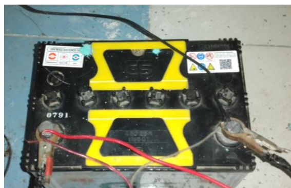
Gambar 3. Komponen teknologi energi hybrid setelah dilakkan perawatan
