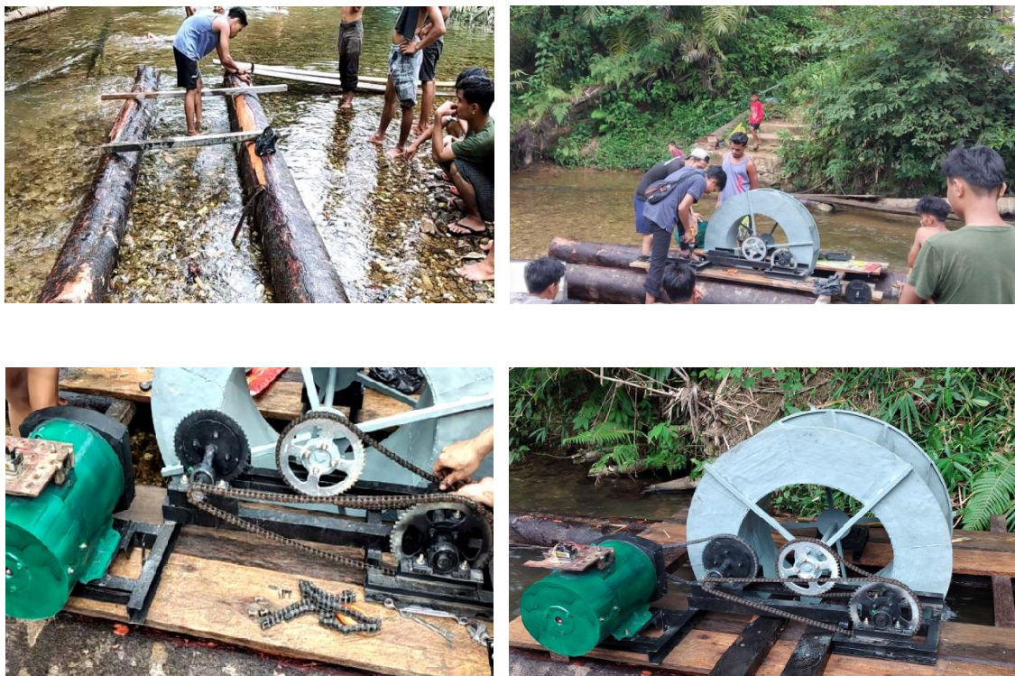
Gambar 2. Proses instalasi pembangkit listrik tenaga piko hidro
