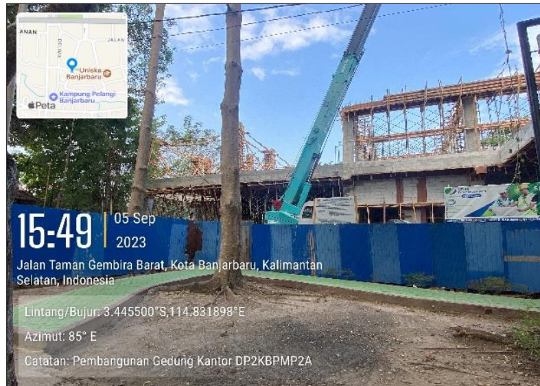
Gambar 6. Kondisi bangunan dengan lahan terbatas
