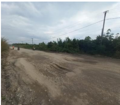
Gambar 1. Kondisi Kerusakan Permukaan Jalan pada STA 0+600 s/d 0+700 Perhitungan Pavement Condition Index (PCI)
