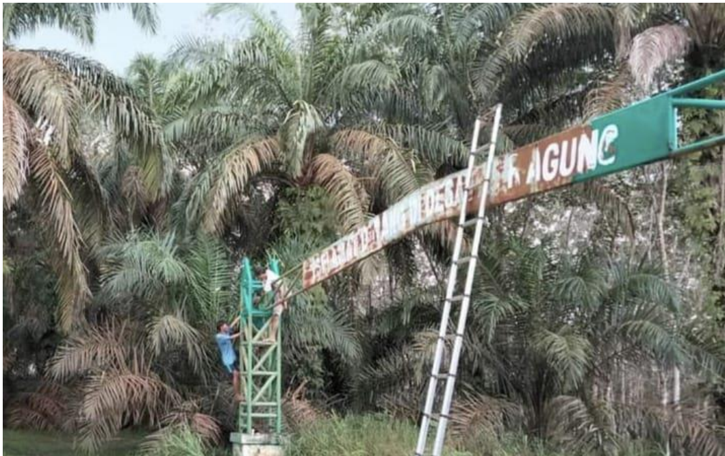
Gambar 5. Pengecatan Gapura Desa Batas Desa Pasir Agung
